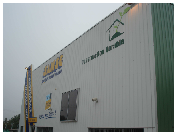
Façade de l'agence SAMSE à la Tour Salvagny
