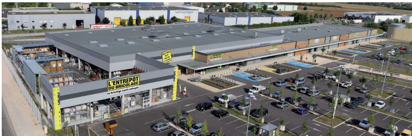
L'Entrepôt du Bricolage à Fontaine-les-Dijon
