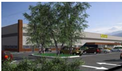
La dernière réalisation du Groupe SAMSE (Entrepôt du Bricolage de Grenoble) est dotée d'une toiture photovoltaïque de plus de 4 000 m 2 en partenariat avec EDF-EN.
