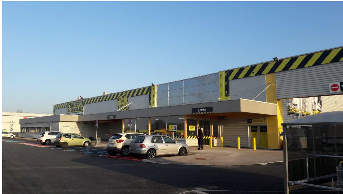
Margencel (Haute-Savoie) : ouverture en février 2017
